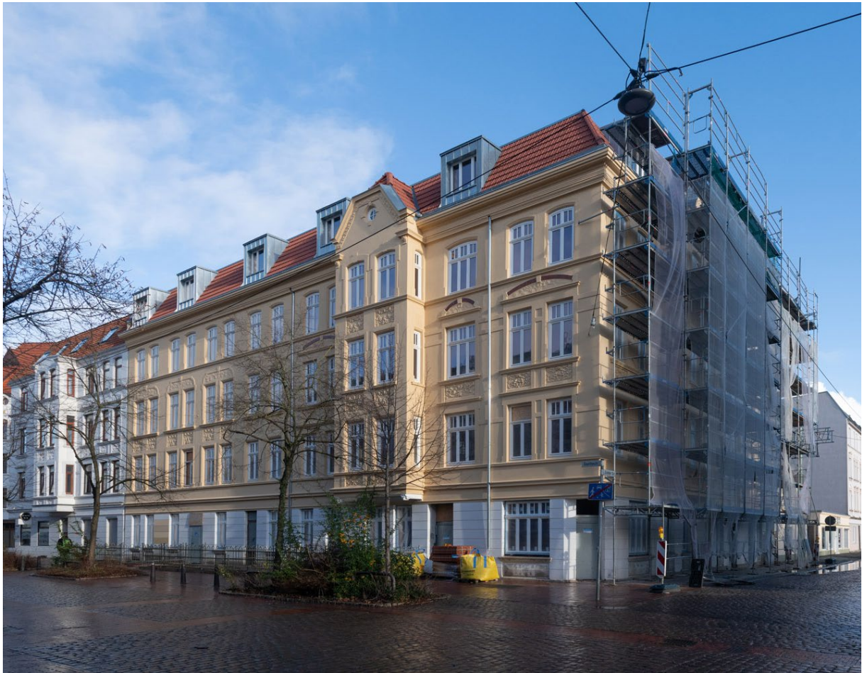
Neuer Glanz im Viertel: Das Quartiersbildungszentrum zeigt sich mit frischer Fassade.
